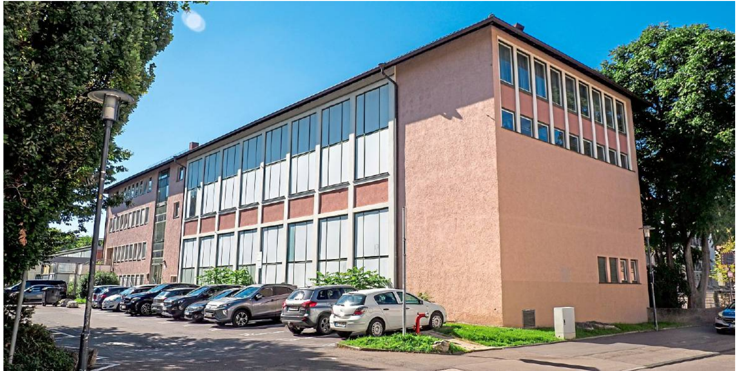
1957 gebaut, ist die Doppelturnhalle am Dragonergässle/Ecke Alleenstraße mit hohem CO 2 -Ausstoß und hohem Heizungsaufwand eine Umweltschleuder. Die energetische Sanierung inklusive Technik und Aufzug hat jetzt die Verwaltung auf die Tagesordnung gebracht. Foto: Holm Wolschendorf
